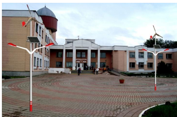
Рис. 3. Вид школьного двора после установки энергосберегающей системы освещения (компьютерный монтаж).
