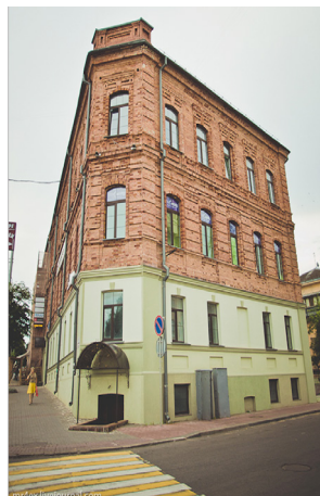
Здание на ул. Ленина, 16. Здесь находится галерея Николая Дундина «Стена».
