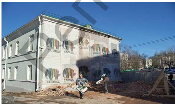
Ремонт здания. 2008 год.
