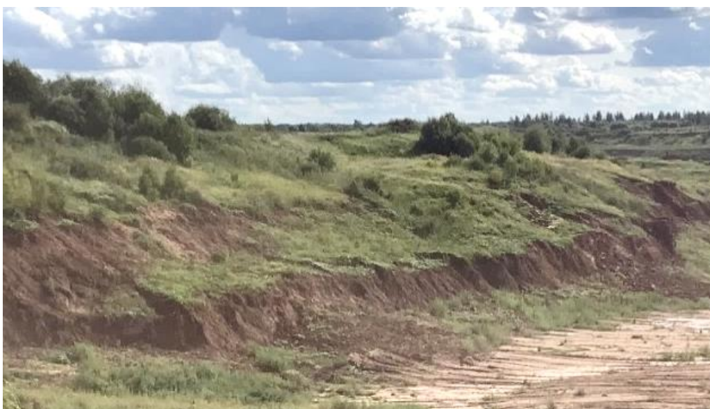
Рис. 1. Фрагмент фронтального оползня выдавливания в восточном борту карьера «Лукомль-1» (фото А.Б. Торбенко, 2023)
