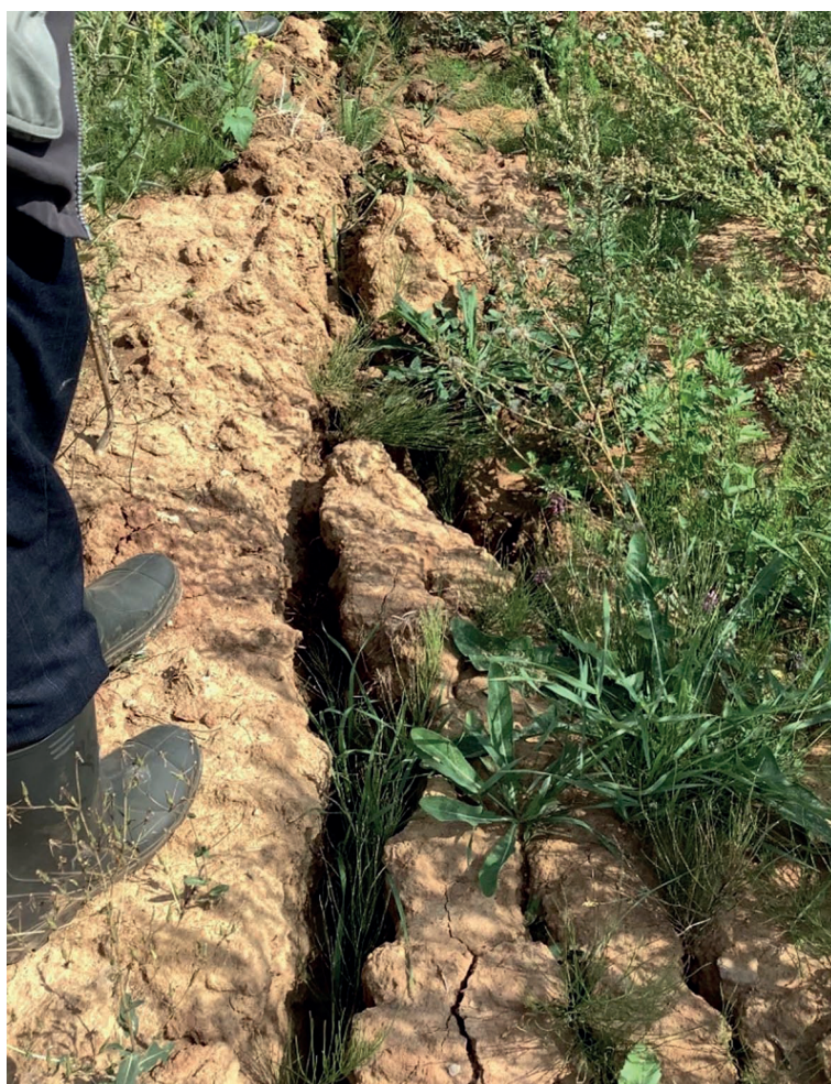
Рисунок 7 – Трещины на поверхности грунтового массива вдоль главного оползневого уступа в северо-восточной части карьера
