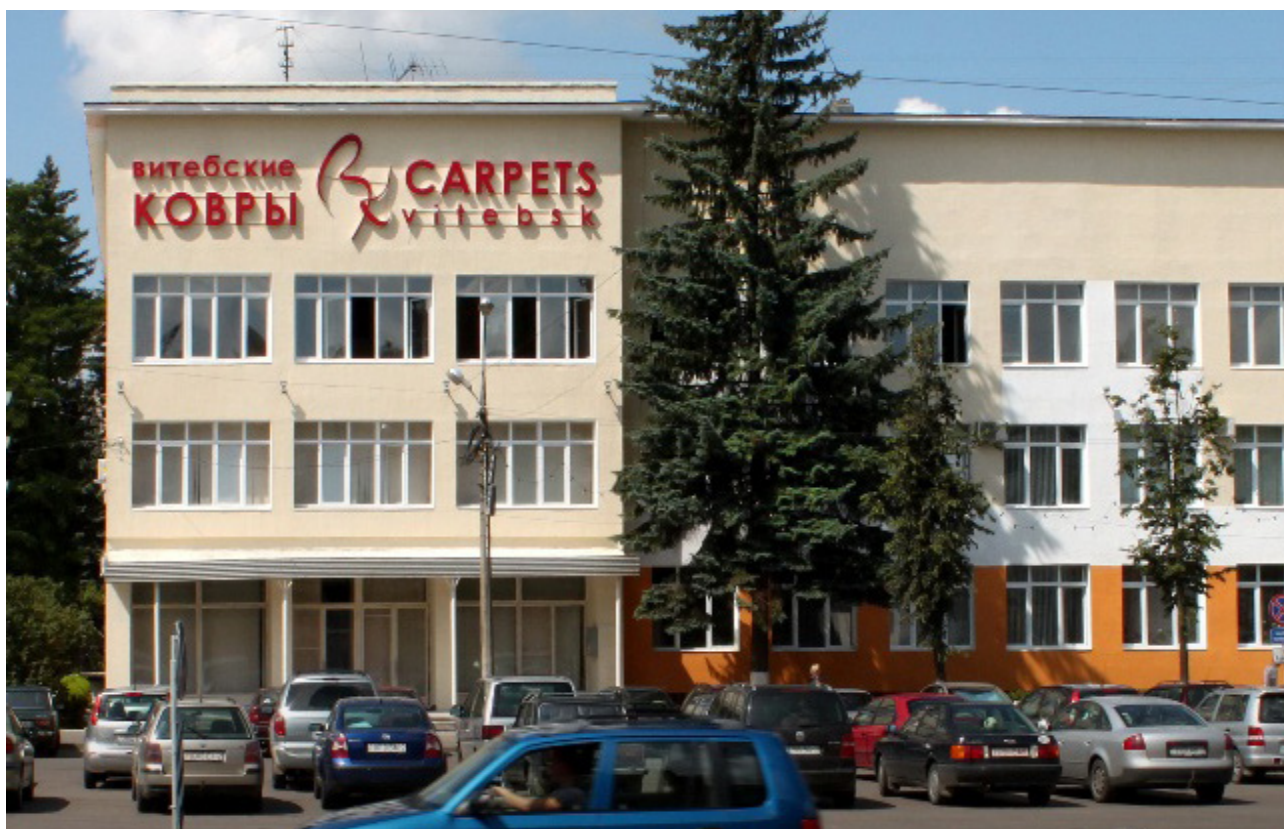
Главный корпус ОАО «Витебские ковры»
