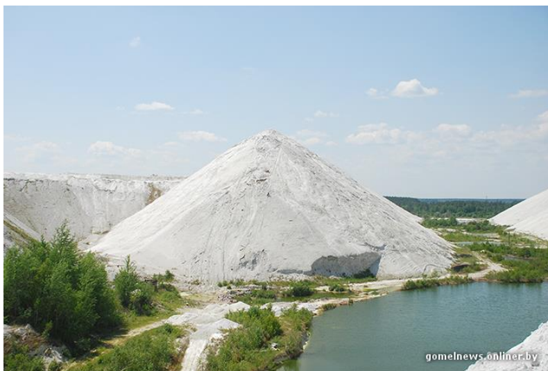
Рисунок – Отвалы фосфогипса Гомельского химического завода
