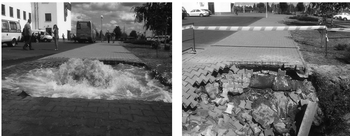
Рис. 4. Прорыв водопроводной трубы, вызвавший суффозионный размыв грунта, и его последствия вблизи Ледового дворца в Гомеле (по http://gomel.today , 2013).
