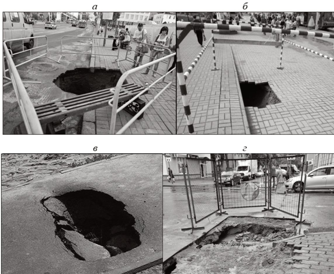
Рис. 5. Деформации тротуаров, вызванные суффозией: а, б) в Витебске вблизи Летнего амфитеатра (2011 и 2012); в) в Гомеле вблизи парка «Фестивальный» (2020); г) в Бресте на перекрестке улиц Мицкевича и Куйбышева (2020) (по [7–10]).
