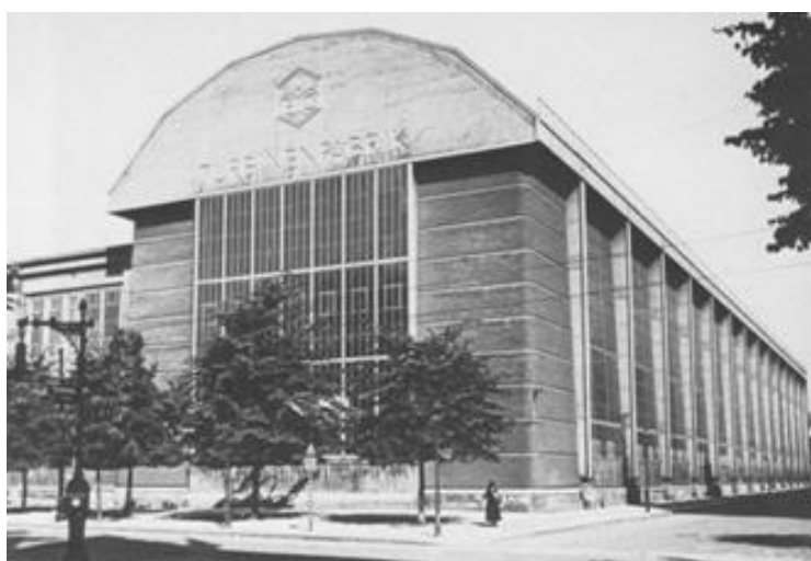
Рисунок 2 – Турбинный завод, построенный для AEG в 1909 г.
