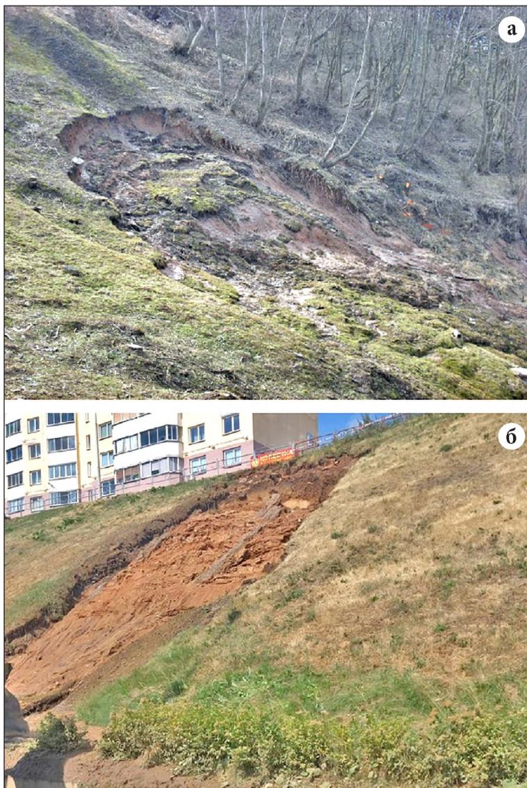
**Рисунок 6** – Оползни-потоки на левом склоне оврага «Гапеевский» по Московскому проспекту (а) и склоне дорожной выемки по ул. Воинов-интернационалистов (б) в Витебске (фото А.Н. Галкина, 2008, 2021)
