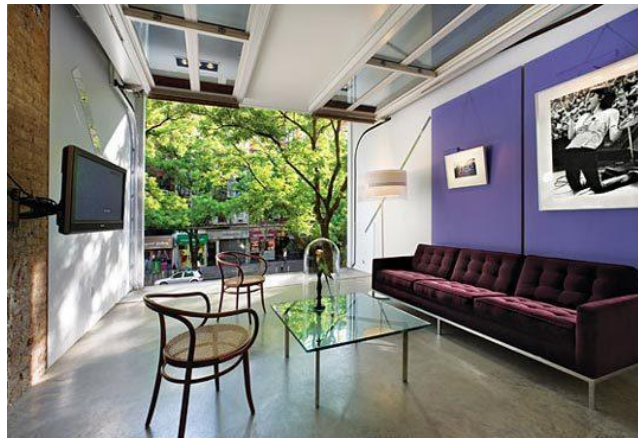
Рис. 47. Глухая стена фасада была просто разрушена и заменена на мобильную раздвижную стену-роллет. Когда стена находится в закрытом положении, проходя мимо, вы вряд ли отличите ее от простого фрагмента городского здания, благодаря вполне традиционным оконным проемам ( http://newcomebel.com.ua ).
