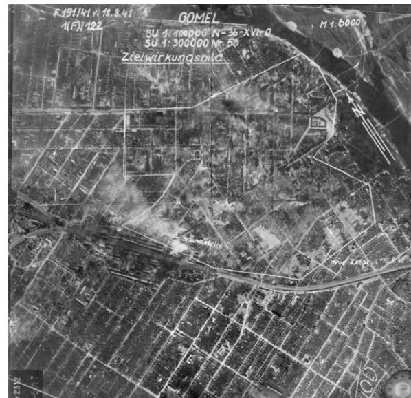
Рисунок 4 – Восстановленная автором аэрофотосъёмка Гомеля, 18 августа 1941 г.
