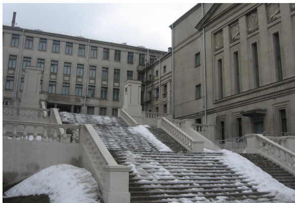
Рис. 8. Лестница Дома офицеров
