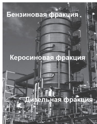
Рис. 5. Фотография ректификационной колонны ОАО «Нафтан», дополненная текстом о получаемых фракциях нефти
