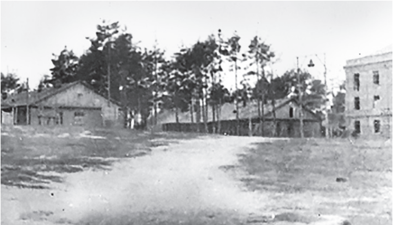
Рис. 2. На фото лазаретные бараки (слева направо) № 11, № 12, фрагмент 3-этажного корпуса № 18. ГАМО. – Ф. 1408. Оп. 1. Д. 3. Л. 54
