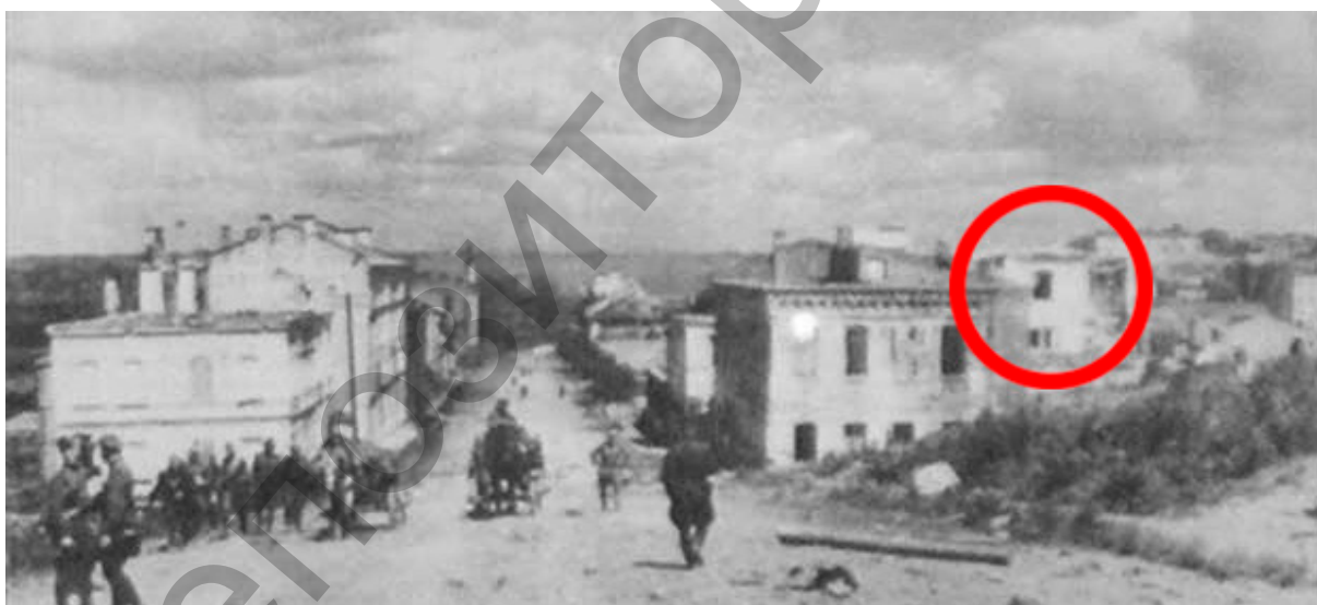
Фото улицы Калинина. 1944-50 г. Справа видна разрушенная Воскресенская церковь с наполовину разрушенной апсидой
