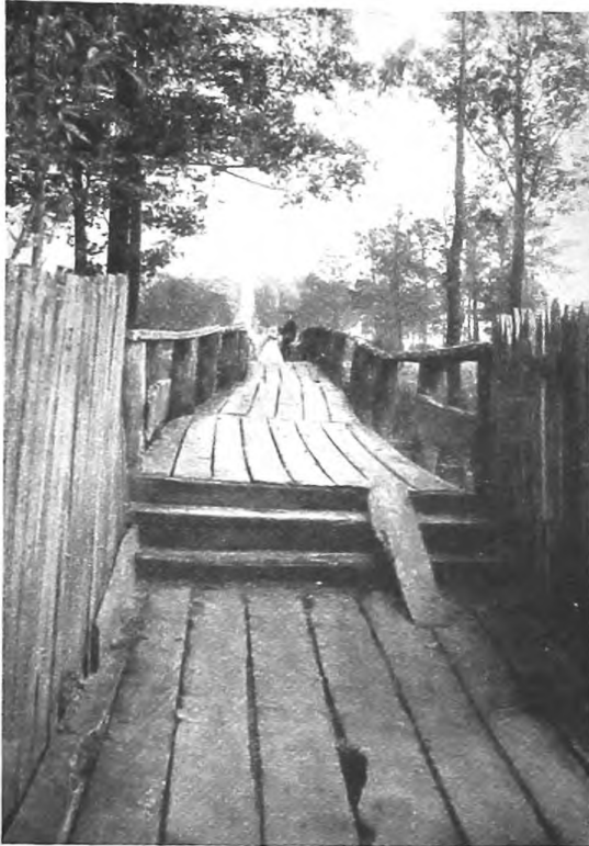
Рис. 21. Мостки къ церкви Пресв. Троицы въ с. Вербкахъ.
