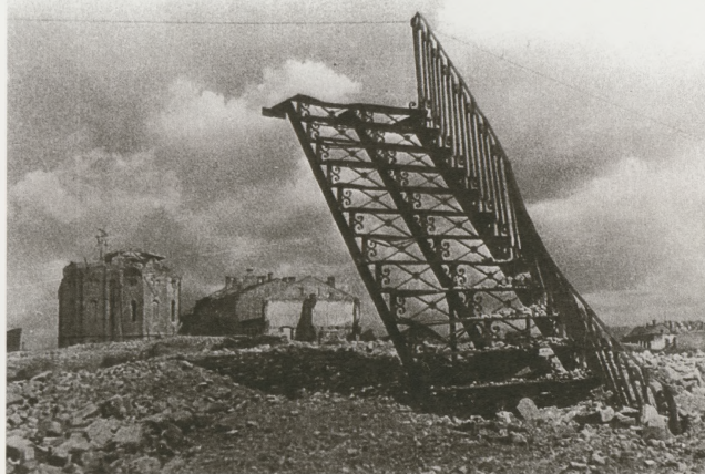
На снимке: район бывшего Могилевского рынка (начало улицы Калинина). Взорванная водонапорная башня («Лестница в небо»), июнь 1944 года. Фото предоставлено В. Борисенковым.
